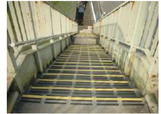
大阪府 歩道橋段鼻
