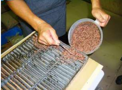
⑤Σ03と骨材を混合したものを; ヘラ等を用いて入れる
